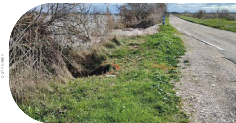
› Février 2026, une petite crue dégrade la digue en aval de Salin-de-Giraud
