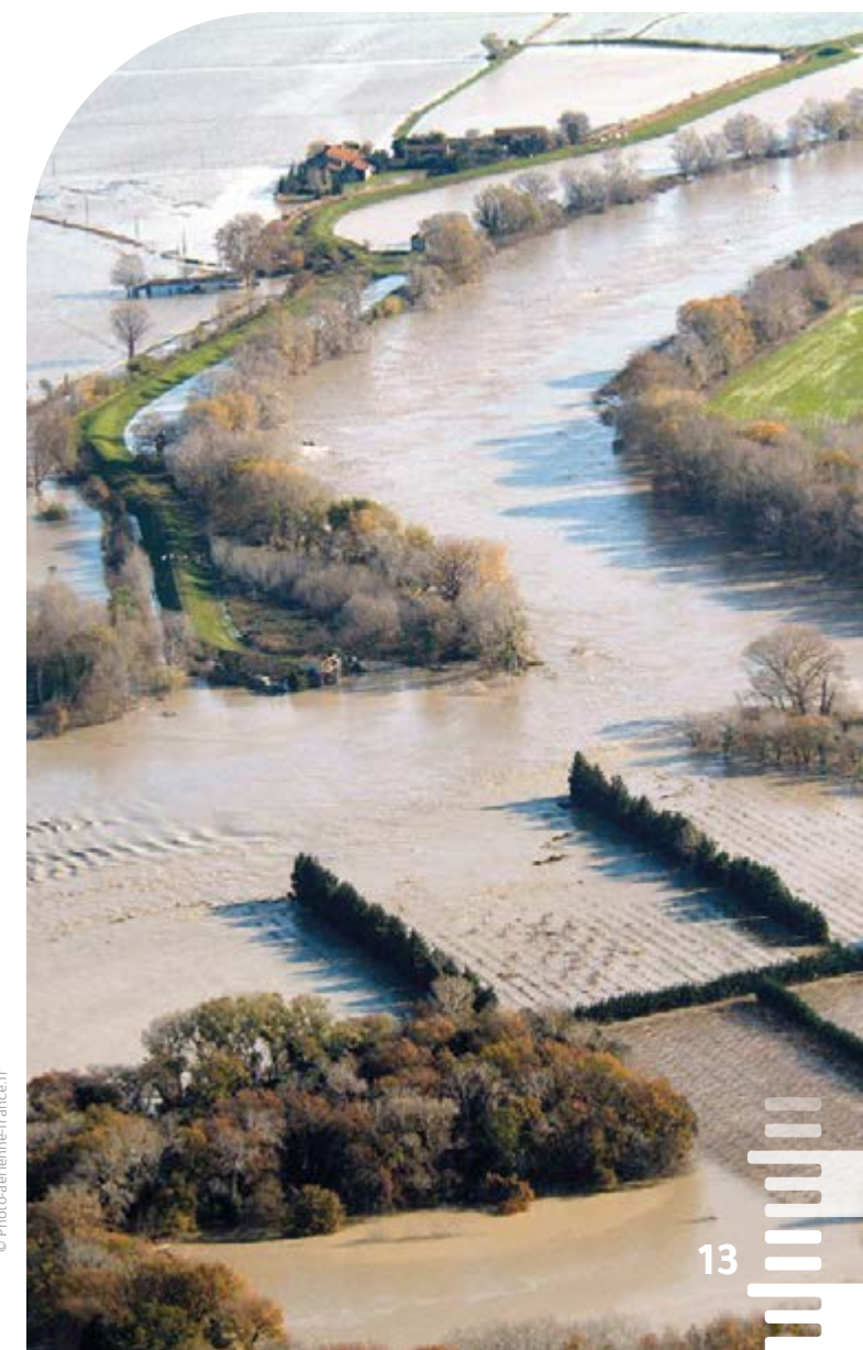
► La brèche de Petit Argence du 3 décembre 2003
