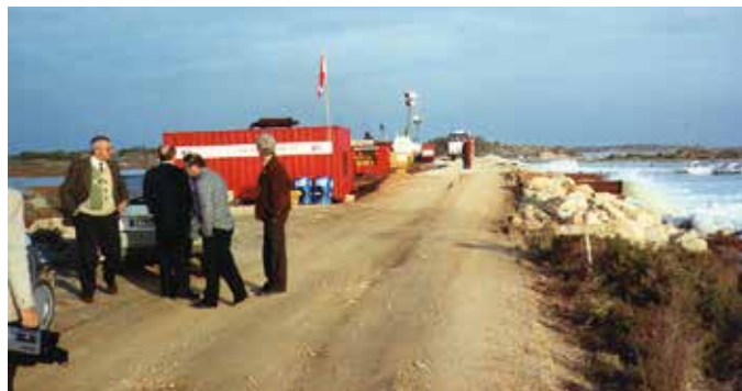
Ressuyage à la suite des inondations de 1993 en Camargue insulaire
