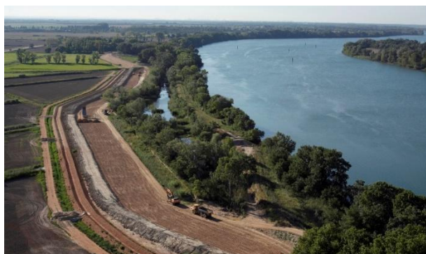
Photo 3. Démontage des digues et reconstruction en recul du fleuve et création de zones humides (© Symadrem)
