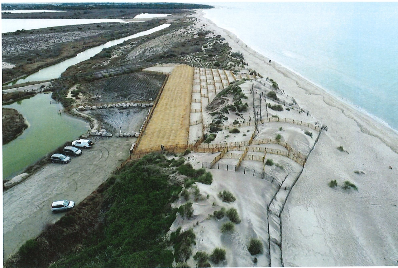
Vue aérienne du secteur des travaux dunaires (sources Symadrem/EID, 2023)
