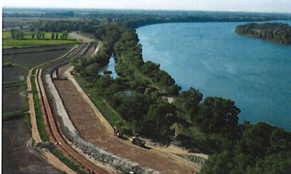
Photo 3. Démontage des digues d'origine, reconstruction en recul et création de zones humides (© Symadrem)
