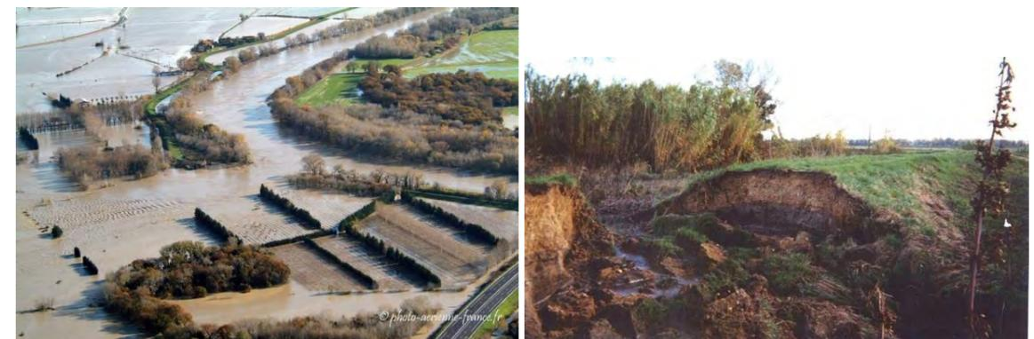
Photo 11. Exemple de brèche à gauche (© P. Blot) et de départ de brèche à droite (© BRLi)
