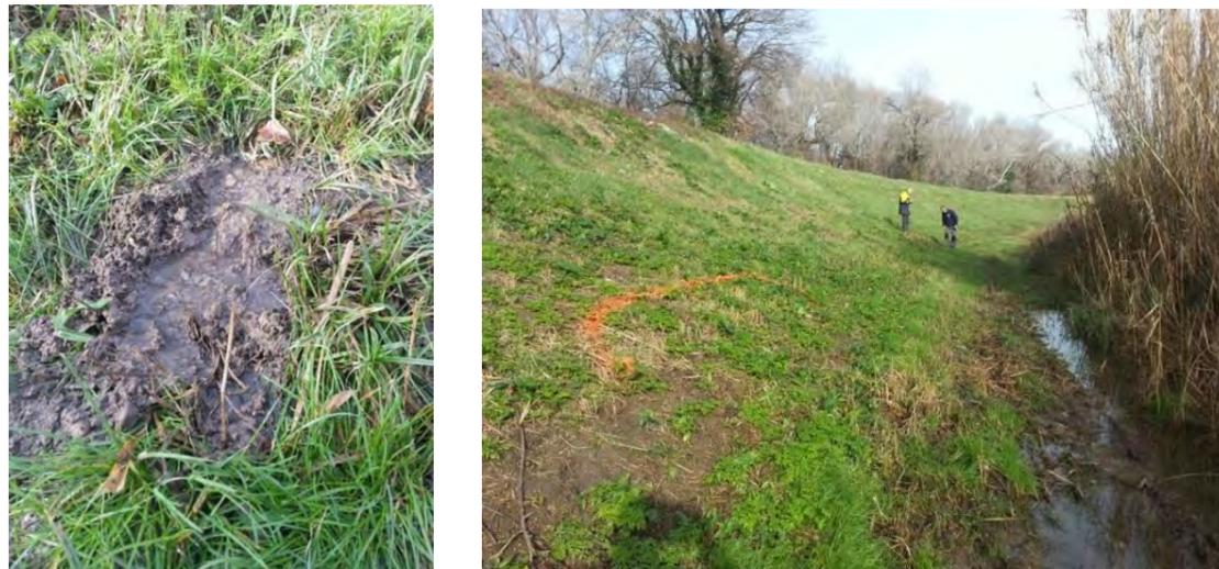
Figure 35. Scénario de brèche n°4 : érosion de conduit le long d'une fissure traversante
