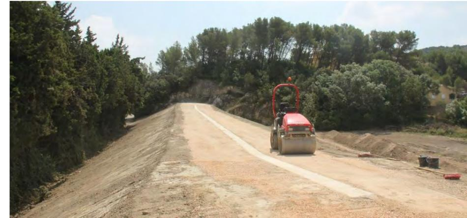
Photo 8. Tronçon résistant à la surverse du système d'endiguement Marguilliers
