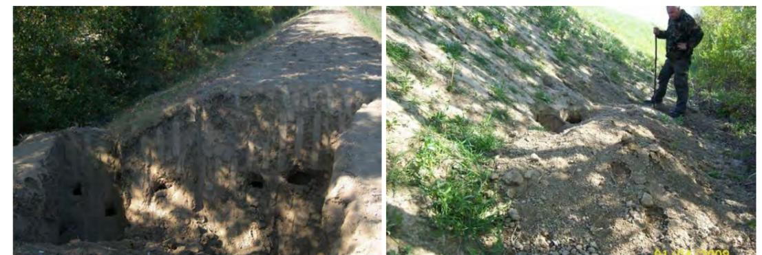
**Figure 31.** Scénario de brèche n°1 : claquage hydraulique d'un terrier partiellement colmaté et érosion de conduit
