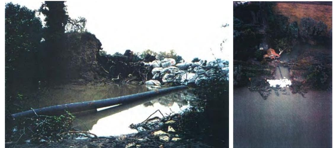
Figure 33. Scénario n°2 : brèche le long d'une canalisation traversante – Casebrune Octobre 1993
