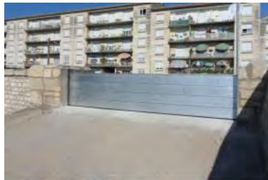
**Photo 26.** Batardeau mis en place lors d'un essai
