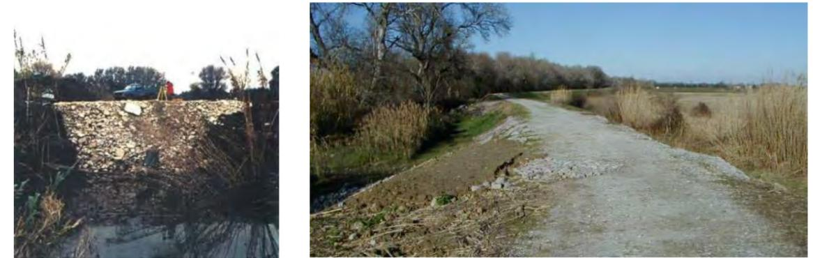
**Figure 38.** Scénario de brèche n°6 : Claquage hydraulique du masque étanche et érosion de contact le long d'une couche de graviers
