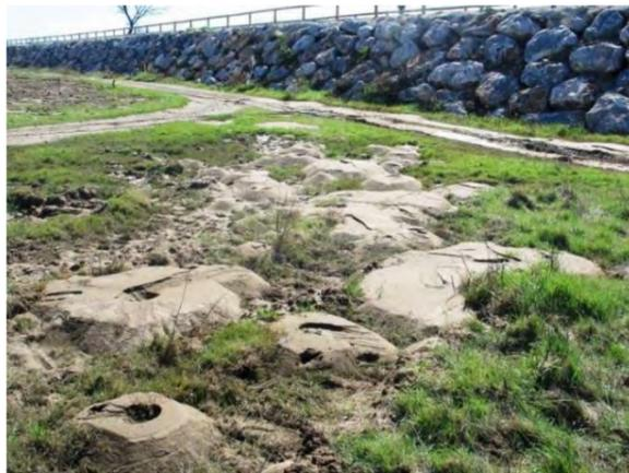
**Figure 37.** Tumulus de sable observé en aval des digues de l'Aggly lors de la crue de 2013 (© SAFEGE)
