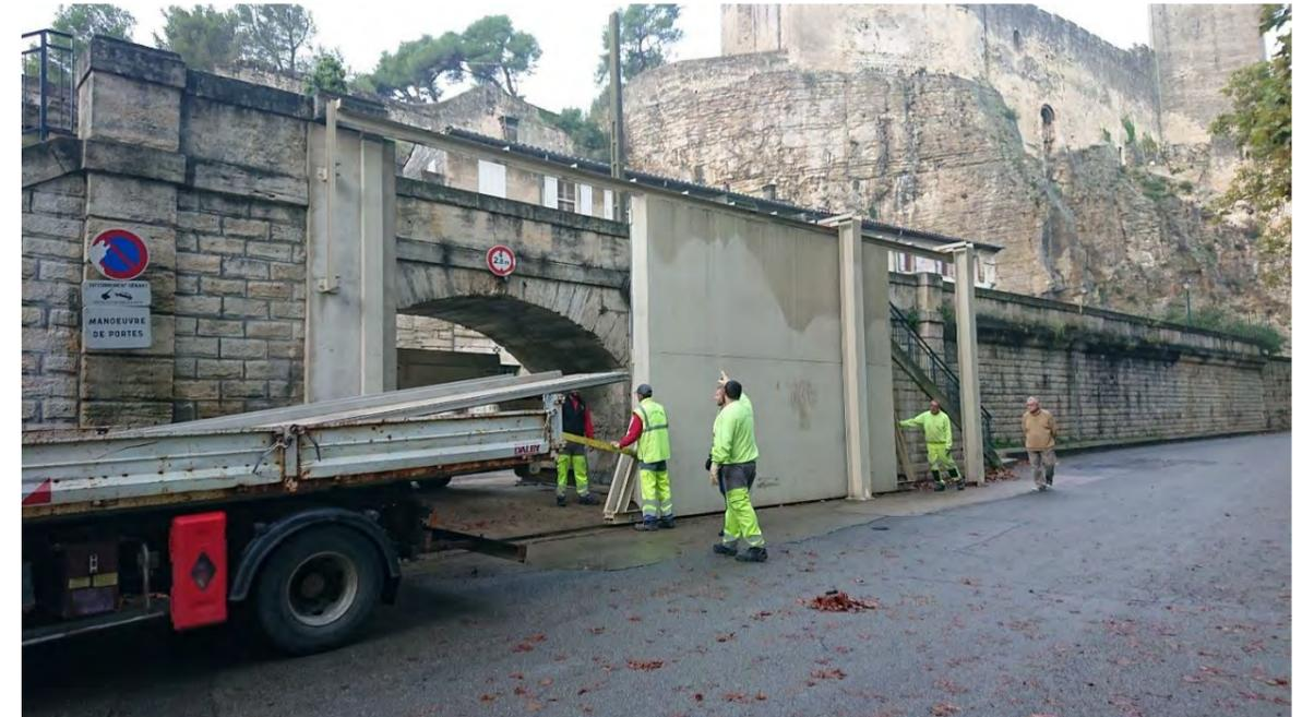
**Figure 131.** Mise en place des portes de Beaucaire (essai du 24 octobre 2019)
