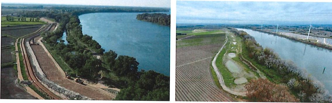
**Photo 3.** Démontage des digues d'origine, reconstruction en recul et création de zones humides
