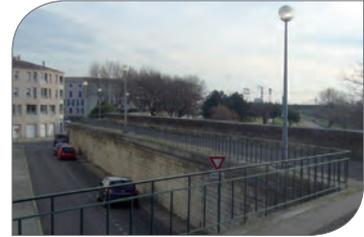
La digue de la montagnette a été confortée et rehaussée suite à la crue de 1840, calée 1,50 mètre au-dessus de la crue observé lors de la crue de novembre 1843. Suite à la crue de mai 1856, elle a fait l'objet de plusieurs projets de rehausse, qui ont été concrétisés par l'aménagement d'un parapet d'une hauteur de 0,60 m en 1872.
