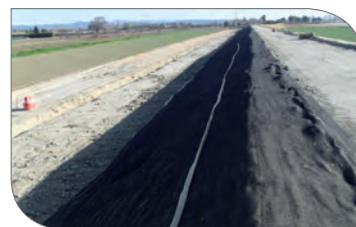
Géogrille sur le talus amont en protection contre le batillage
