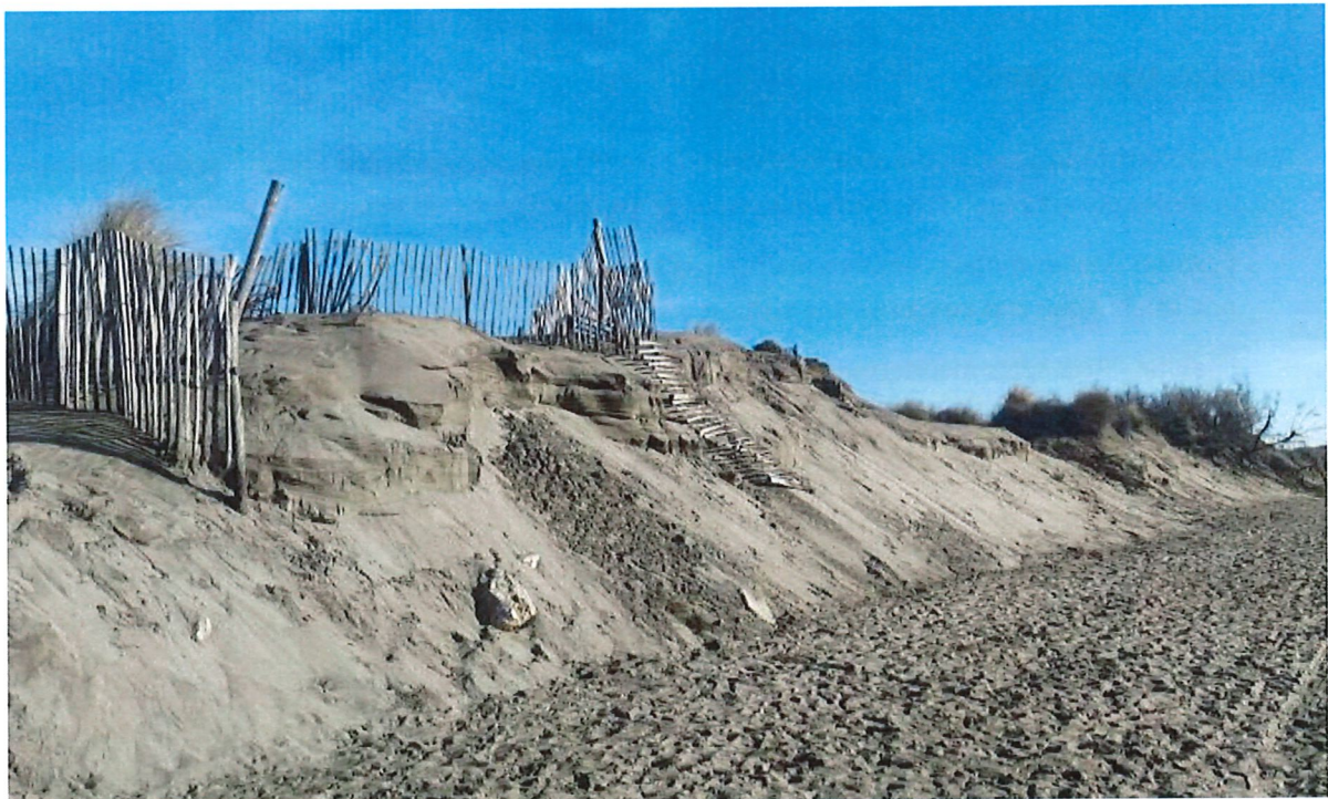
Vue du cordon dunaire côté plage, à l'est immédiat du débouché de l'accès véhicules ; le recul du front dunaire illustre bien le phénomène d'érosion qui touche cette partie du linéaire côtier du Grau du Roi (photo EID 2021)
