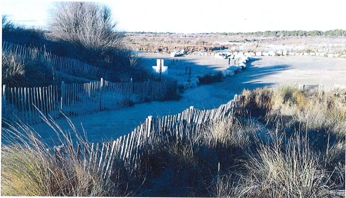
Vue de la partie centrale de l'emprise de l'apport sableux ; l'accès véhicules sera fermé et comblé ; l'aire de stationnement visible en haut à droite sera réduite (photo EID 2021)
