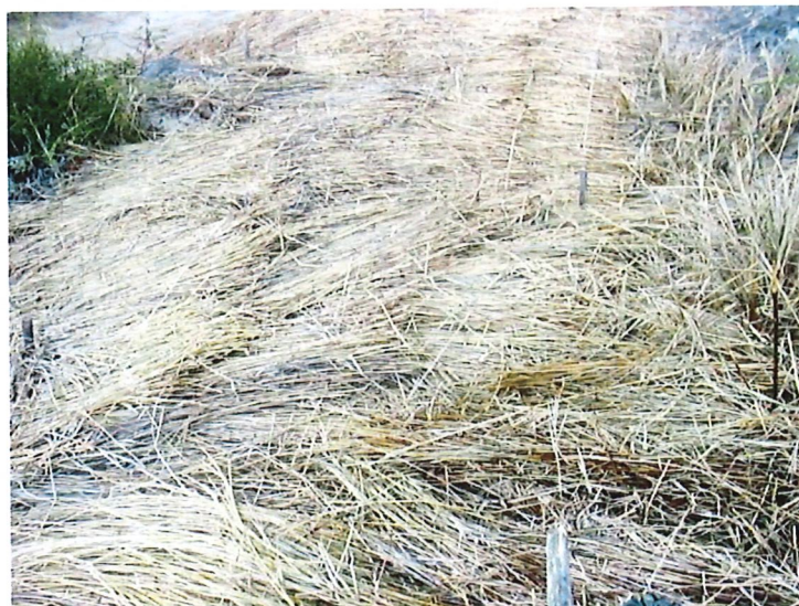
Exemple de paillage dunaire par étalement de roseaux
