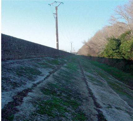
fleuve. Une paroi de 7 cm d'épaisseur dont l'adhérence se faisait au support par scellement de connecteurs (perçement et scellement d'acier par scellement chimique) soit 160 000 perçements à réaliser dans le béton existant !
