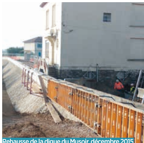
Rehausse de la digue du Musoir, décembre 2015
