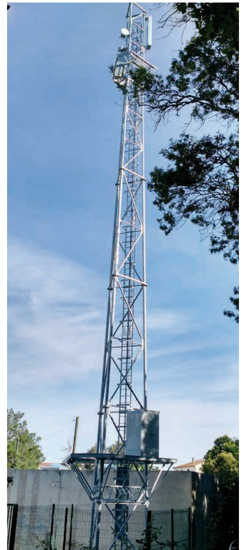
Pylône réseau radio
