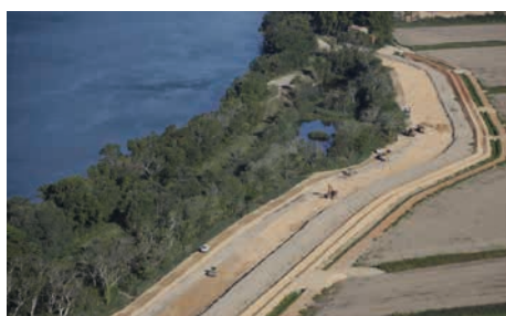
🚧 Digue Sud Arles
