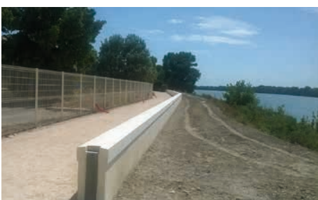
🚧 Digue musée départemental Arles antique
