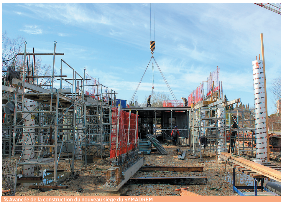
Avancée de la construction du nouveau siège du SYMADREM
