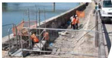
Dans le cadre des travaux de réparation des quais du Rhône en Arles, le confortement de la partie basse du quai de la gare maritime est en cours de réalisation. L'objectif est d'assurer la protection contre les crues du Rhône du quartier de Trinquetaille en :
