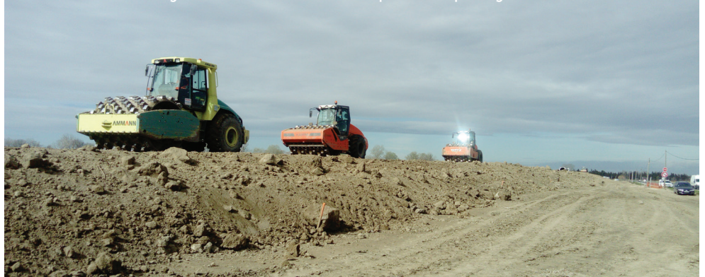
Confortement de la digue entre Beaucaire et Fourques - compactage des matériaux
