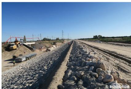
Elle contient les crues centennales sans débordement. Au-delà, elle permet au Rhône de se déverser sans provoquer de brèches. L'autre (5 km) est calée 50 cm au-dessus des niveaux atteints pour une crue millénaire.
