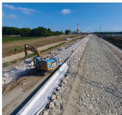
La seconde partie de la digue millénaire au sud est construite, la pose des matériaux drainants s'achève avant la mise en place du grillage anti-fouisseurs et de la terre végétale.
