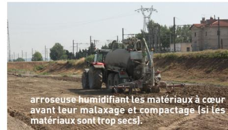
arroseuse humidifiant les matériaux à cœur avant leur malaxage et compactage (si les matériaux sont trop secs).
