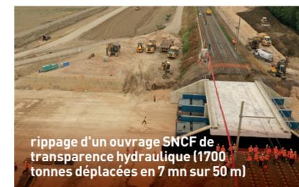
rippage d'un ouvrage SNCF de transparence hydraulique (1700 tonnes déplacées en 7 mn sur 50 m)
