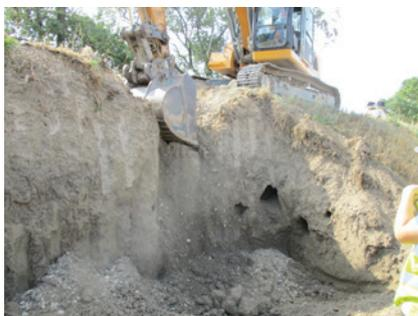
Avant... la constitution du SYMADREM, l'entretien courant des ouvrages n'était pas réalisé régulièrement ni systématiquement par les syndicats locaux. Lors des crues de 1993 et 1994, les 16 brèches et départs de brèche, identifiées étaient dues à un phénomène d'érosion interne, avec 13 cas dus à des terriers d'animaux fouisseurs et 3 cas dus à des traversées de canalisations dans les digues.
