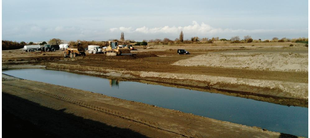
**L**a construction d'un ensemble de trois plots d'essai a été réalisée au mois de novembre 2017 à Salin-de-Giraud. L'objectif du dispositif est de tester la résistance à la surverse de différentes conceptions de digue en utilisant des techniques de construction nouvelles, comme l'utilisation de matériaux traités à la chaux.
