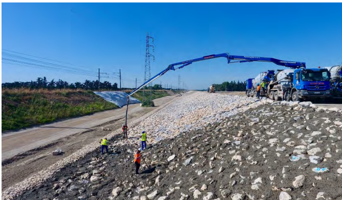
Enrochement du talus côté « zone protégée »
