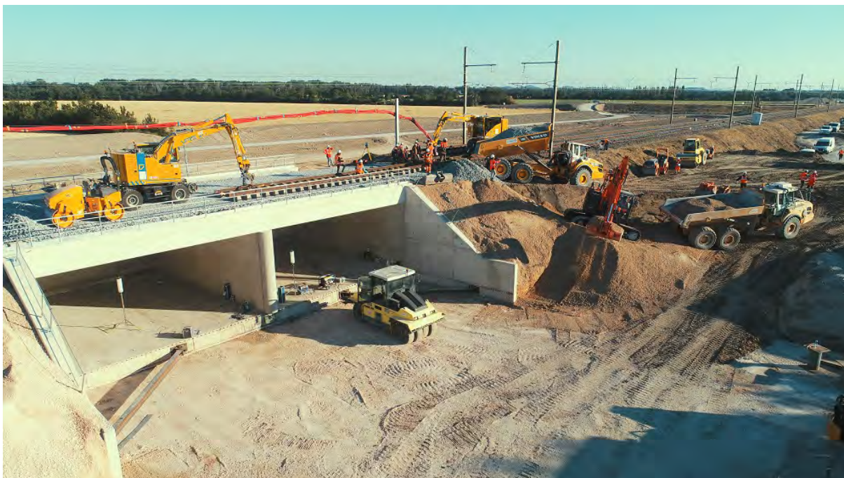
Ouvrage ripé - © SNCF Réseau – Altamétris
