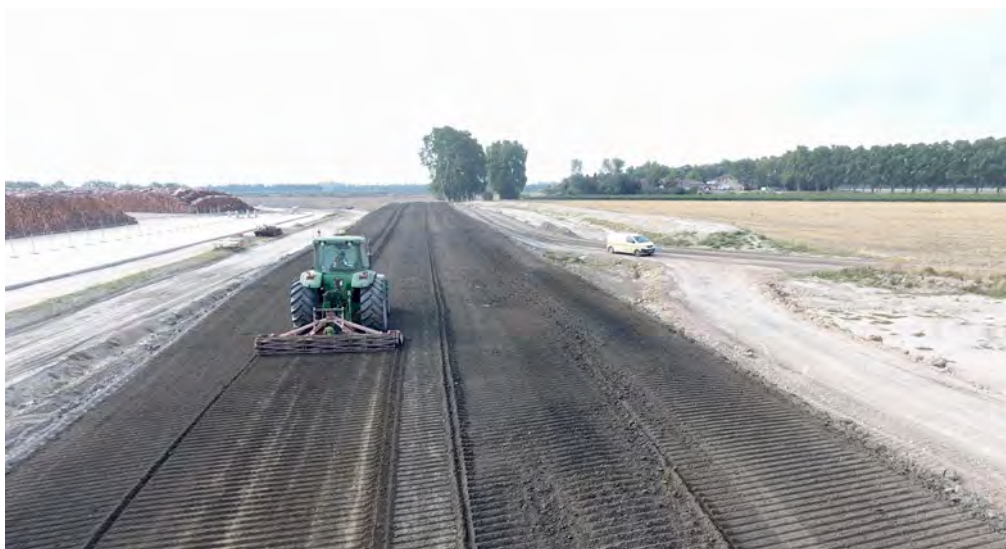
Homogénéisation de la teneur en eau
