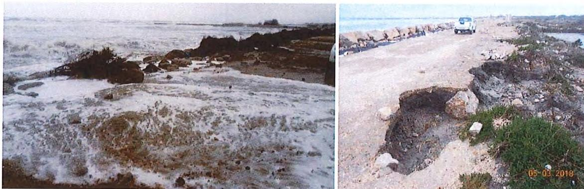
**Photo 1.** Déferlement de vagues et surverse sur la digue à la Mer en mars 2018 (photo de gauche) – départ de brèche par surverse (photo de droite)
