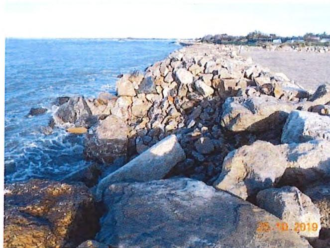
**Photo 2.** Rupture de l'épis tenon du clos du Rhône en octobre 2019
