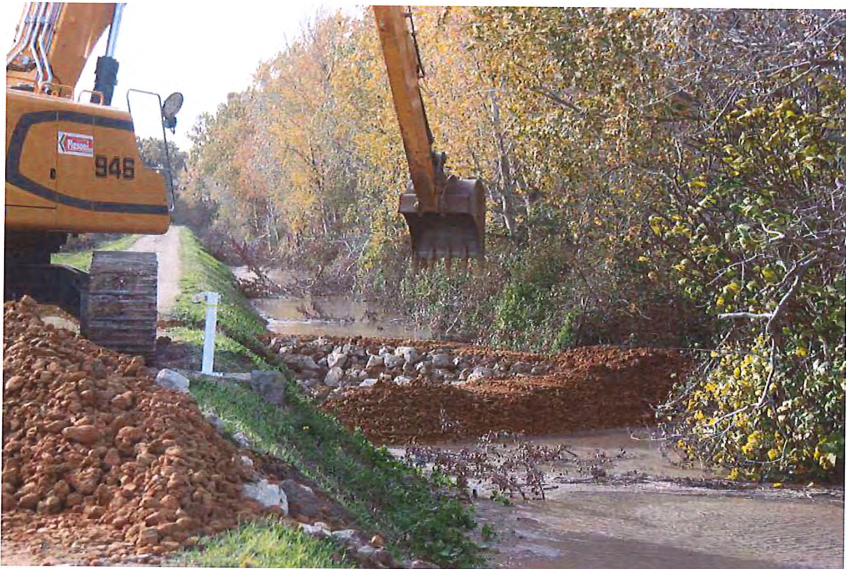
Photo 9. Dépose de matériaux gravelot-argileux côté fleuve – Brèche de Ventabren – PRD le 23/11/2016
