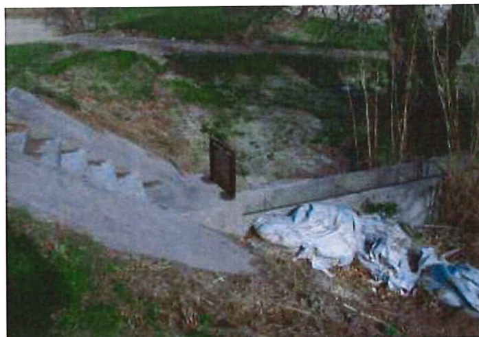
Photo 8. Intervention au droit d'un ouvrage traversant
