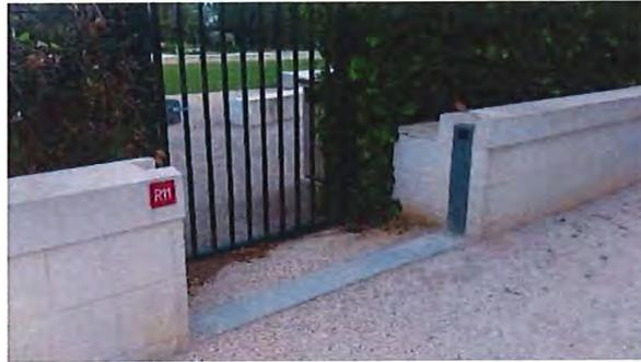
Figure 16. Batardeaux parapet du remblai de l'IRPA (R9, R10 et R11)
