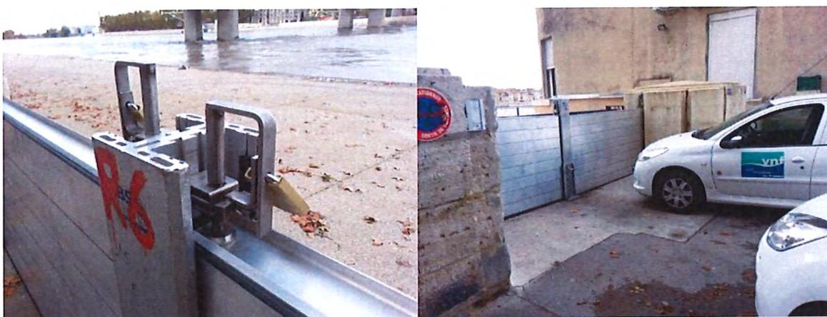
**Photo 6.** Dispositif antivols (à droite) et risque de choc et rupture du batardeau accru en cas d'absence des poteaux urbains (à gauche)
