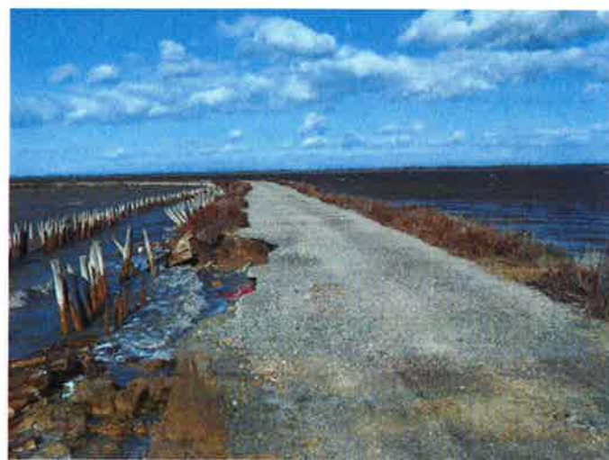
Le tronçon de digue à la mer situé entre le Clos Desclaux et la digue des Toscans est actuellement érodé de façon importante
