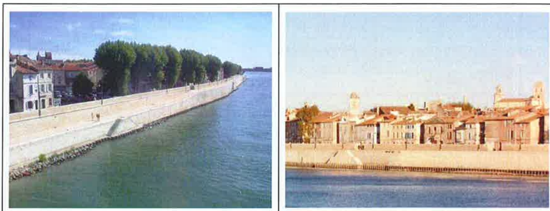
Quai de la Roquette après confortement et reconstruction du secteur effondré
