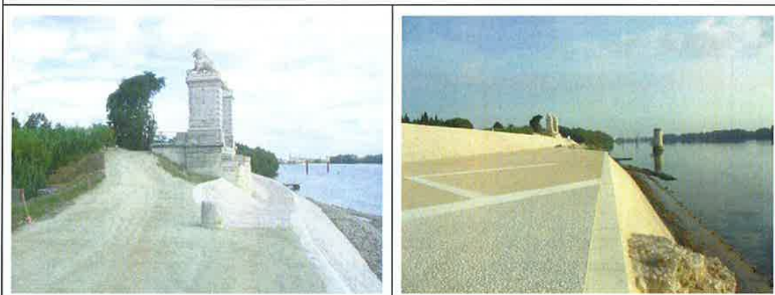
Quai Saint-Pierre amont et cale de mise à l'eau après confortement
