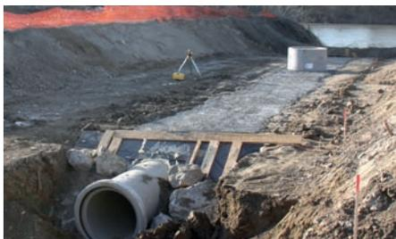
5 - Bétonnage plein fouille et enrobage
