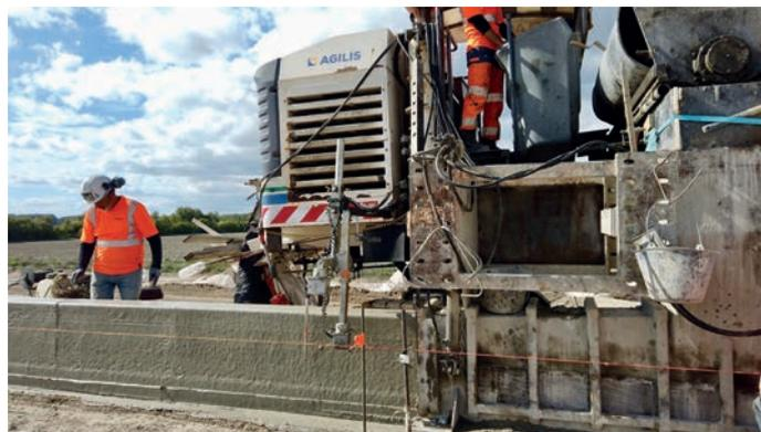
Poutre béton destinée à caler le niveau de surverse...
