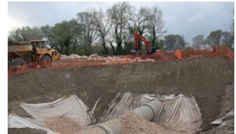
6 - Pose du filtre et drain aval
