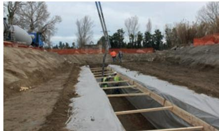
3 - Tranchée et bétonnage du fond de fouilles
