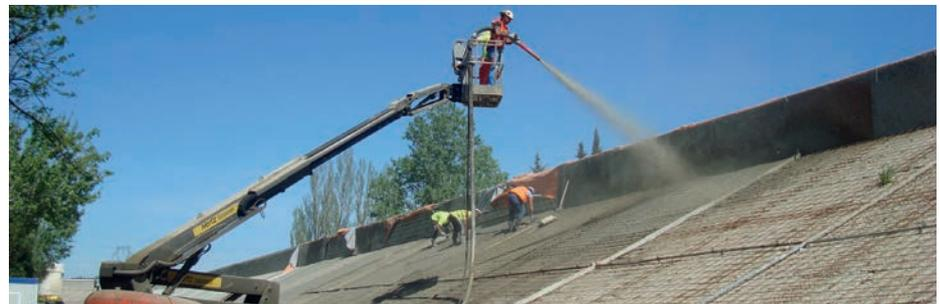
Digue de la Montagnette - réalisation d'un masque étanche en béton projeté
