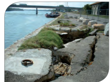
Quai de la gare maritime – érosion interne des remblais en décrue et effondrement du quai (à droite) (source ISL [R 71])
