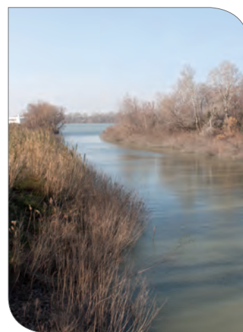
Digue Est d'emboisement de l'écluse d'Arles (VNF)
