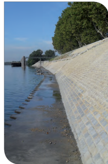
Quai de la gabelle (SYMADREM) conforté en 2010
