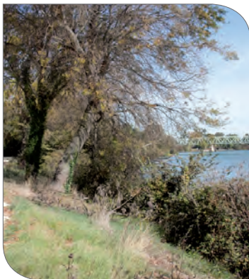
Digue du Petit Rhône de l'aval du Pont de Sylvérial au Mas du Juge rendue carrossable en 2010 (SYMADREM)
