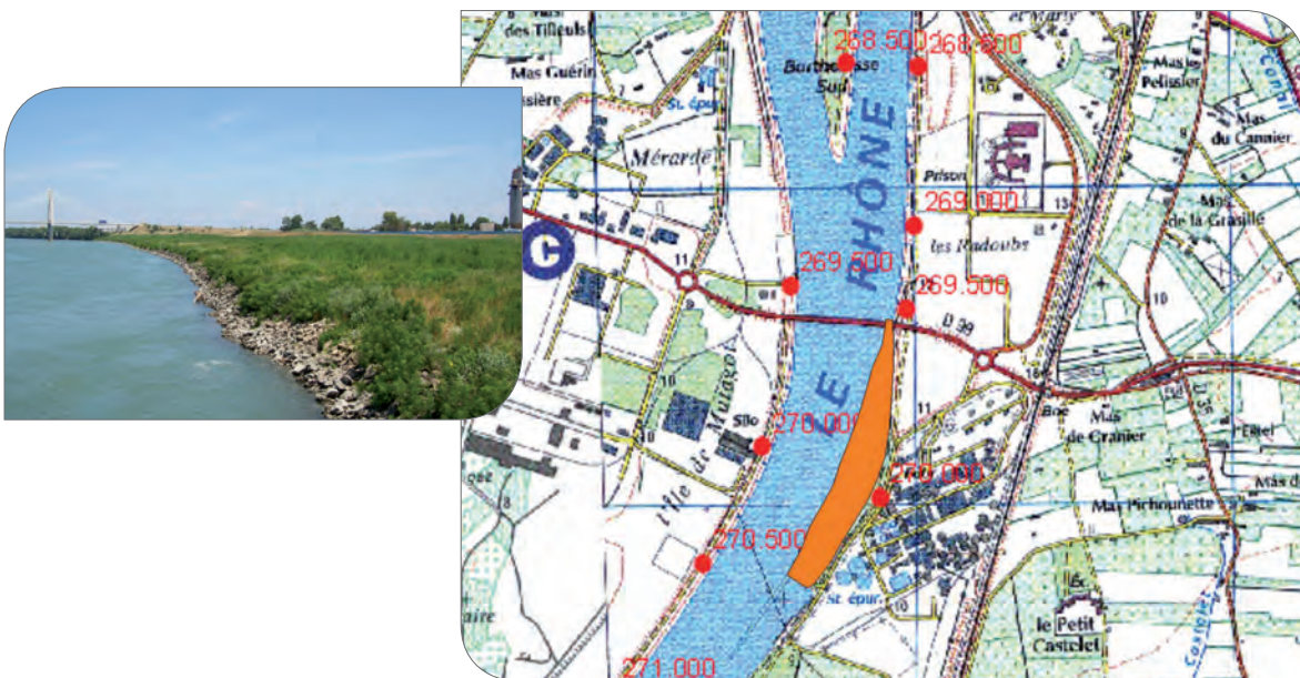
Dragage de l'atterrissement au droit de l'usine Tembec
