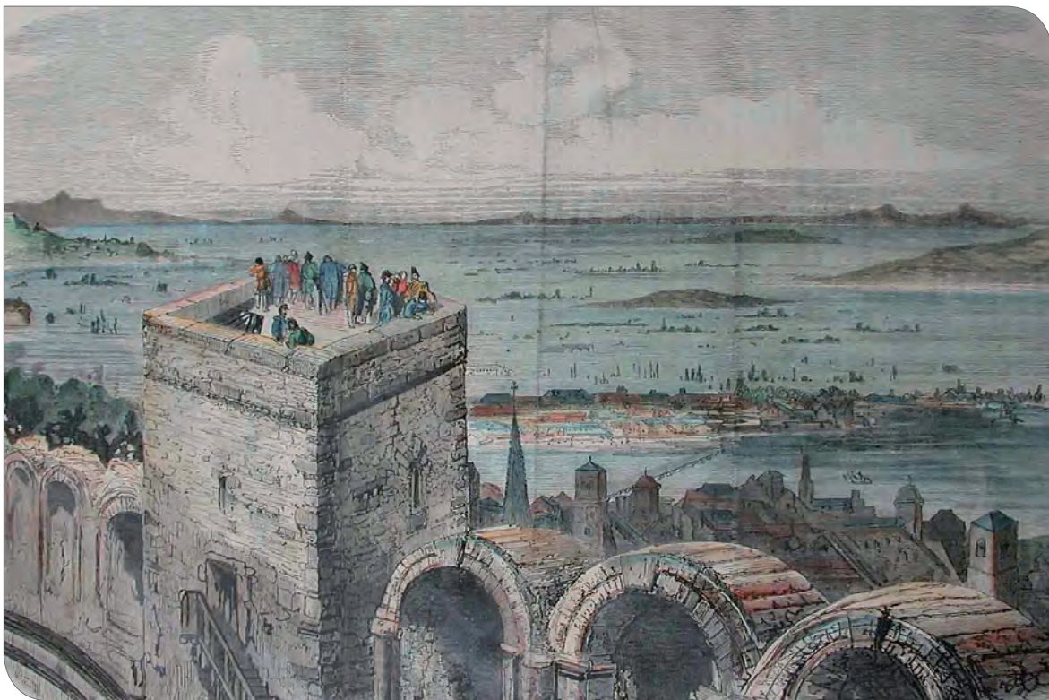
Vue des arènes d'Arles sur la Camargue inondée après la crue de mai 1856 (©Ville d'Arles)
