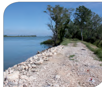
Digue de Salin-de-Giraud traversée du village – travaux de 2 e urgence suite à la crue de déc. 2003 (SYMADREM)
