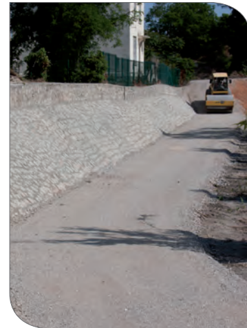
Digue du musoir – secteur compris entre le pont ferroviaire et l'écluse de Beaucaire, confortée en 2011 (SYMADREM)
