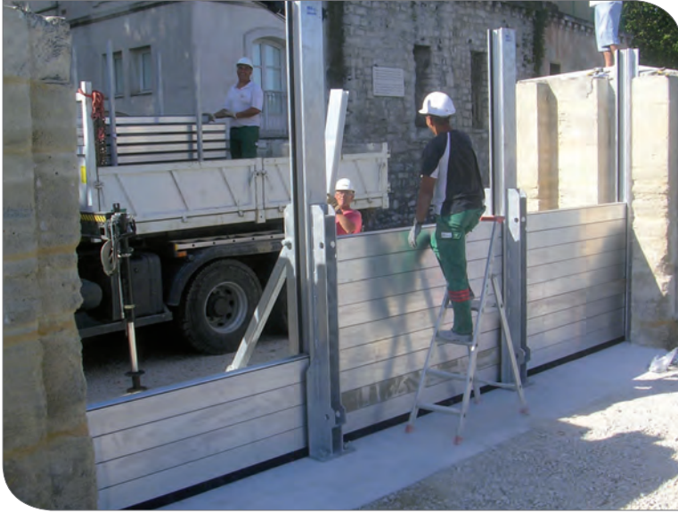
Remplacement des batardeaux en bois par des batardeaux aluminiums
