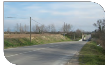
Remblai du Mas Molin (à gauche) reliant le SIP d'Arles au remblai ferroviaire (CNR)
