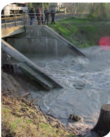
Trémies du remblai ferroviaire Tarascon/Arles (© ville Tarascon)
