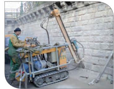
Forage de drains sur le parement aval de la digues
