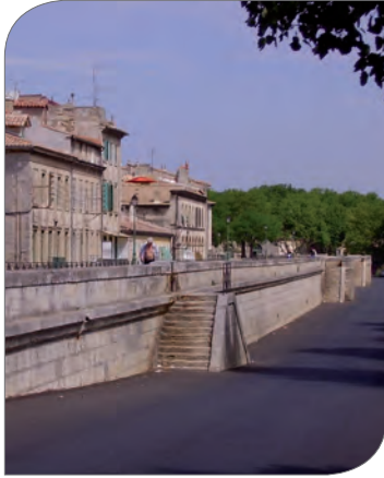
Digue de la Banquette à Beaucaire confortée en 2009 (SYMADREM)
