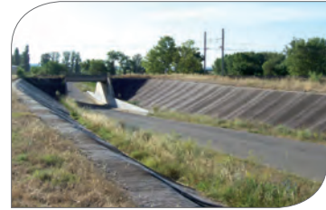
Digues de protection des trémies du remblai ferroviaire relayant la protection au droit des passages sous voie – Elles sont au nombre de trois entre Tarascon et Arles (SNCF)
