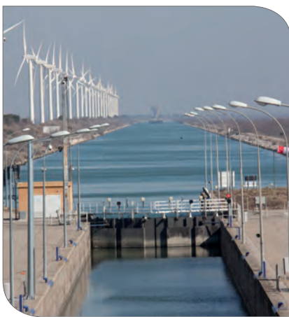
Prise d'eau du canal du Rhône à Fos (CNR)
