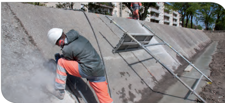
Digue de la Vierge – reprise de l'étanchéité du parement amont
