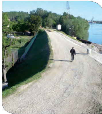
Digue de raccordement du défluent aux quais confortée en 2009 (SYMADREM)
