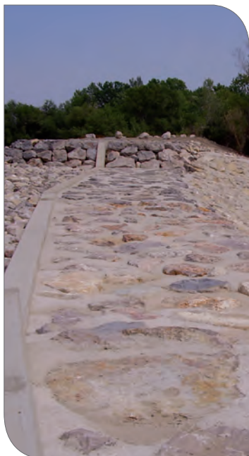
Déversoir de Comps (CNR)
