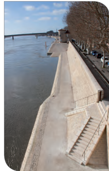
Quai trinquetaille conforté en 2010 (partie basse VNF / partie haute SYMADREM / côté ville commune d'Arles)
