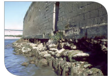
Fondations du quai de la Roquette avant intervention (source ISL [R 71])
