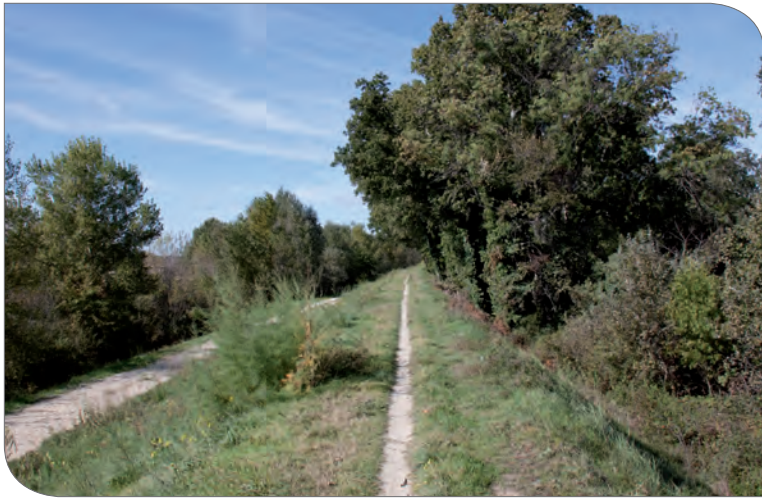
Digue de Cazeneuve confortée en 1997 (SYMADREM)
