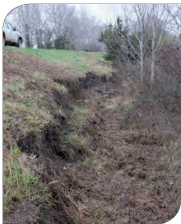
Glissement de la berge et de la digue au droit du mas Marignan suite à affouillement externe
