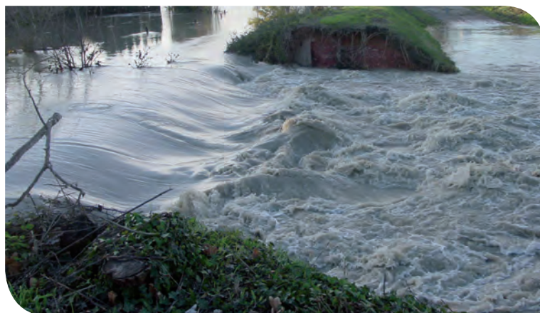
Brèche dans les digues de protection des trémies ferroviaires (© ville Tarascon)
