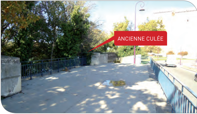
Ancienne culée du pont suspendu
