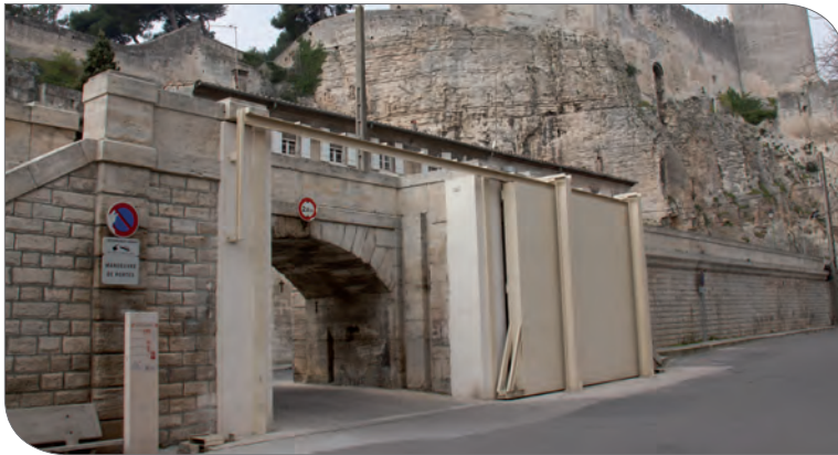
Digue de la Banquette confortée et portes coulissantes rehaussées en 2009 (SYMADREM)
