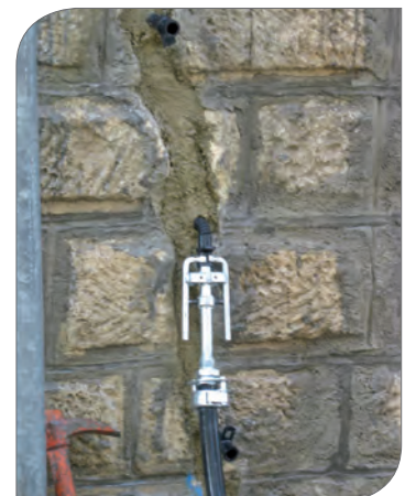
Injections de fissures traversantes
