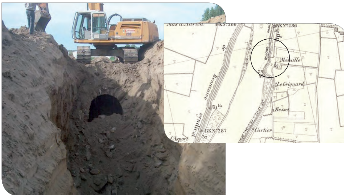
Purge d'un ouvrage traversant masqué au droit du mas médaille suite à l'observation d'infiltrations en crue - Carte des Ponts et Chaussées de 1876 confirmant cette présence
