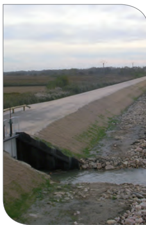
Digue de Port-Saint-Louis confortée en 2006 (SYMADREM)
