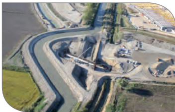
Construction du siphon de transfert sous le Vigueirat
