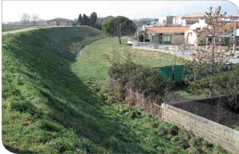
Digue du Rhône au droit de Fourques (SYMADREM)
