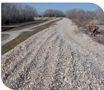
Digue dite du fer à cheval raccordement SIP aux digues du SYMADREM (CNR)
