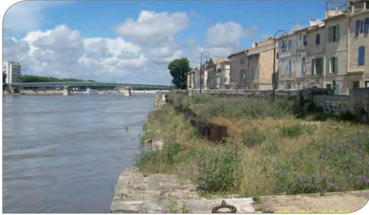
Quai de la Roquette – effondrement de quai fin des années 1970 traité partiellement par battage d'un rideau de palplanches
