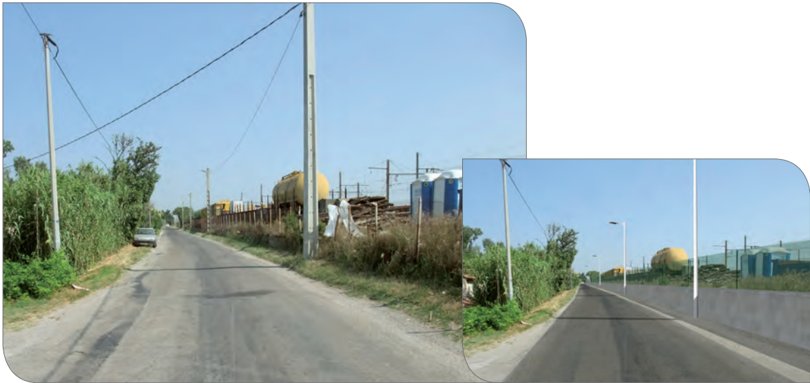
Reprofilage du chemin des ségonnaux à Q_{1000} et création d'un parapet à Q_{1000} + 50 cm
