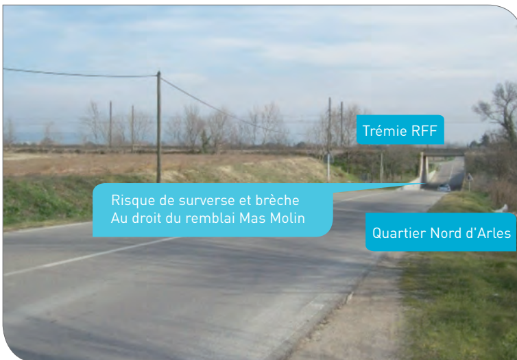
Remblai CNR raccordant le SIP d'Arles au remblai ferroviaire Tarascon/Arles (Digue du Mas Molin)
