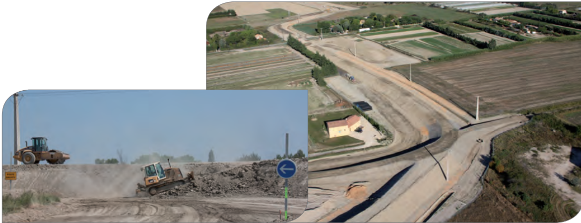
Barreau de fermeture en cours de construction
