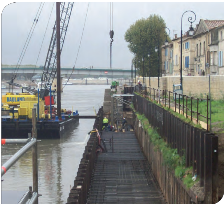
Réparation du quai de la Roquette – reconstruction du mur effondré
