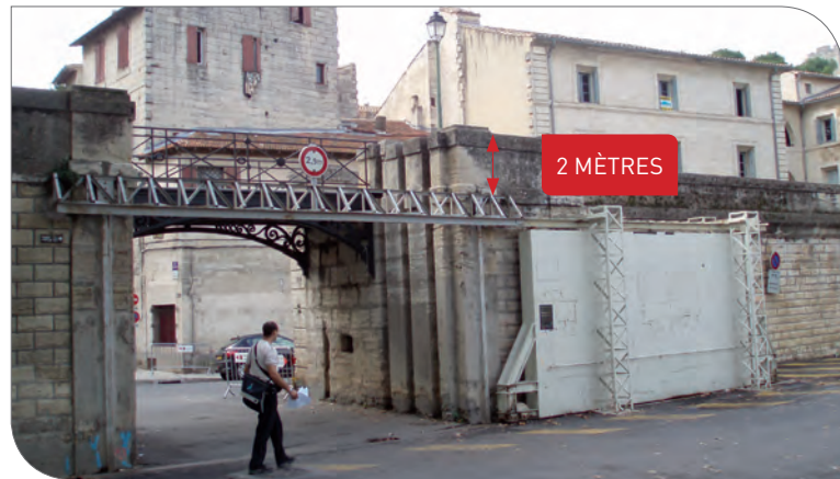
Porte métallique digue de la Banquette avant travaux
