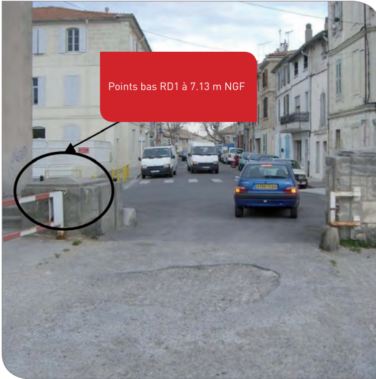
Batardeau VNF quai de la gare maritime (source CNR [R 16])
