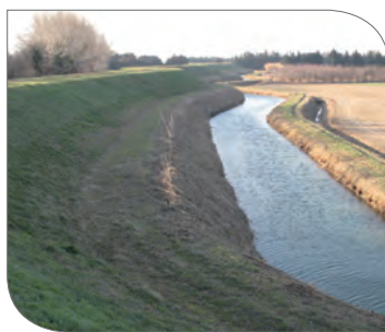
Digue du Rhône du fer à cheval à la station BRL (SYMADREM)
