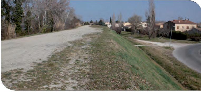
Digue de trinquetaille confortée en 1997 (SYMADREM)
