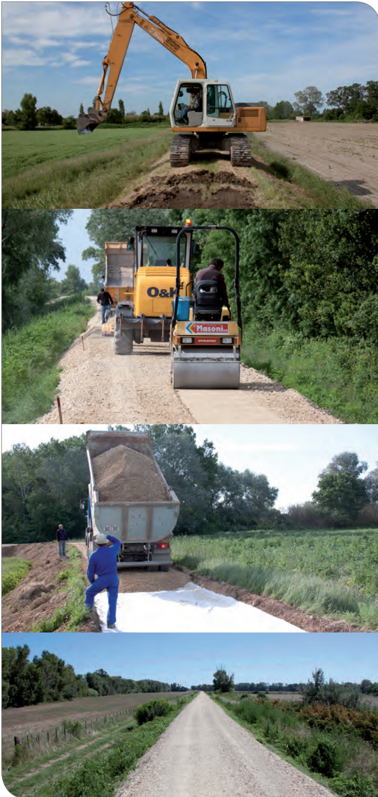
Chantier de carrossabilité
