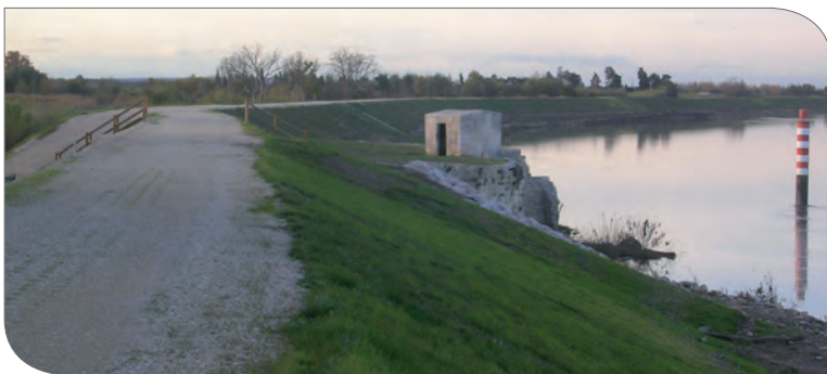
Digue d'Emmaüs à Petite Montlong confortée de 1998 à 2006 (SYMADREM)
