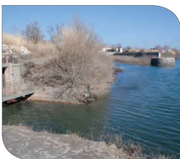
Prise d'eau du canal des Italiens englobée dans la digue des Italiens (ASA Nourriguier)
