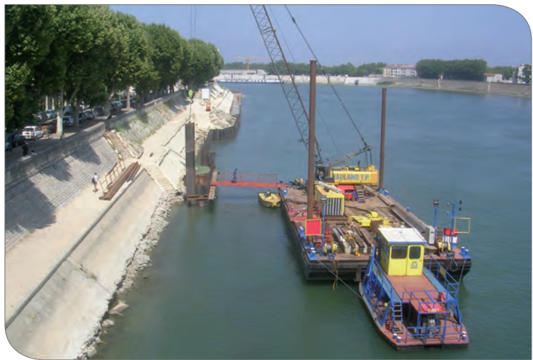
Remplacement des batardeaux en bois par des batardeaux aluminiums
