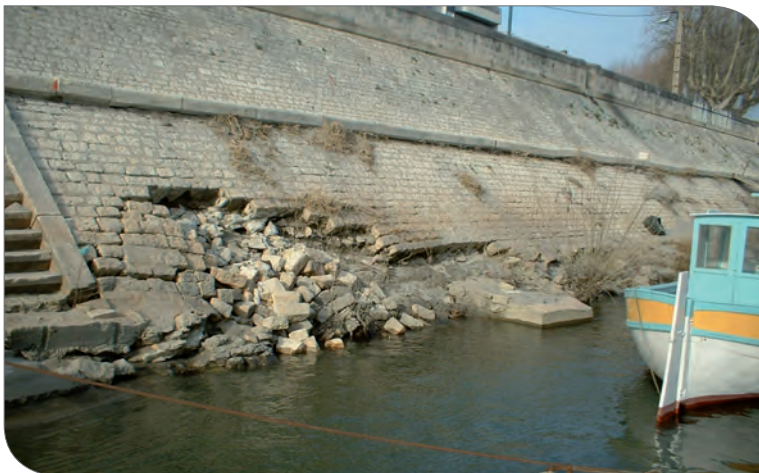
Quai Trinquetaille – glissement du talus suite à affouillement de pied (à gauche)
