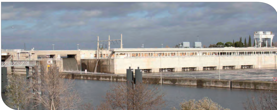
Usine hydro-électrique de Beaucaire (CNR)
