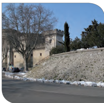
Raccordement digue de la montagnette/ Mur du Château Royal de Provence (SYMADREM)
