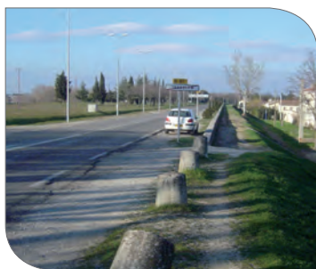
Digue de la montagnette adossée au remblai routier le long du RD81 (SYMADREM)
