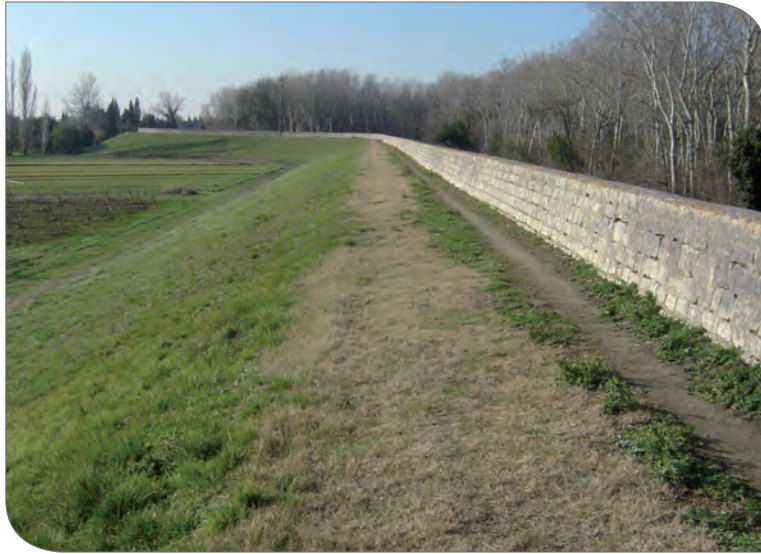
Digue de la Montagnette – talus aval (SYMADREM)
