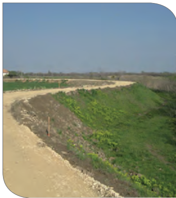
Digue du Petit Rhône en aval de Capette rendue carrossable en 2010 (SYMADREM)
