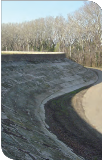
Digue de la Montagnette – talus amont (SYMADREM)
