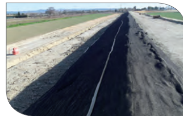
Géogrille sur le talus amont en protection contre le battillage
