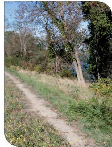
Digue du Petit Rhône en aval de l'Écluse de Saint-Gilles (SYMADREM)
