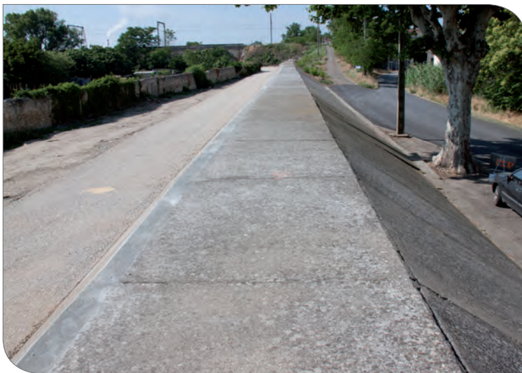
Digue de la Vierge – secteur compris entre le pont de Beaucaire et le Viaduc Ferroviaire confortée en 2011 (SYMADREM)
