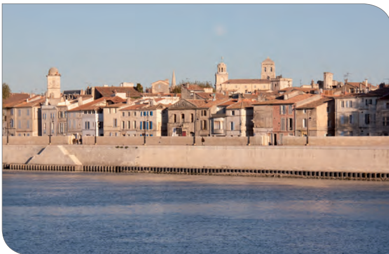
Quai de la roquette conforté en 2009 (partie basse : VNF – partie haute côté Rhône SYMADREM et partie haute côté ville – ville d'Arles)
