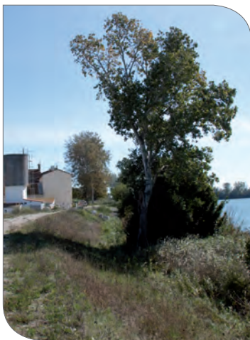
Digue d'Albaron confortée en 2005 (SYMADREM)
