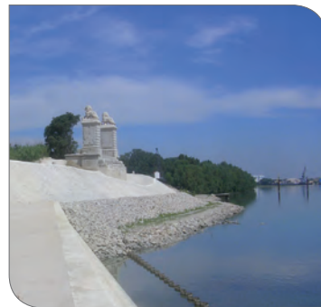
Quai Saint Pierre conforté en 2009 (partie basse VNF / partie haute SYMADREM / côté ville commune d'Arles)
