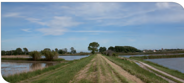
Digue de Salin-de-Giraud traversée du village – travaux de 2 e urgence suite à la crue de déc. 2003 (SYMADREM)
