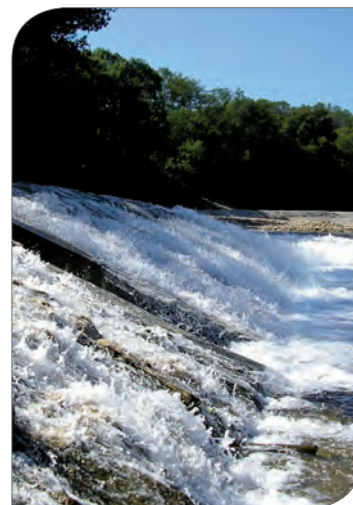
Déversement sans rupture sur un seuil en rivière sur la Cèze
