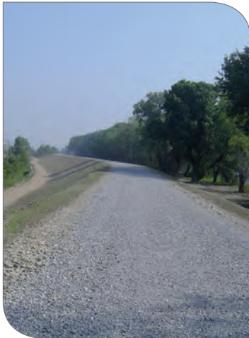
Digue du Petit Rhône de Grand Cabane à l'Écluse de Saint-Gilles confortée en 2007 (SYMADREM)
