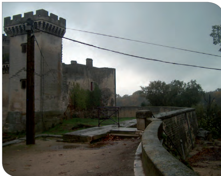
Mur du Château Royal de Provence (SYMADREM)
