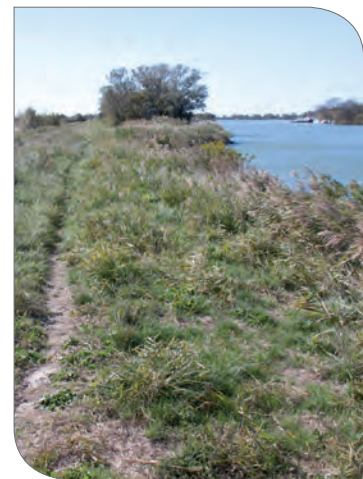
Digue aval Mas d'Icard (SYMADREM)
