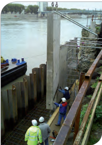
Réparation du quai de la Roquette – reconstruction du mur effondré
