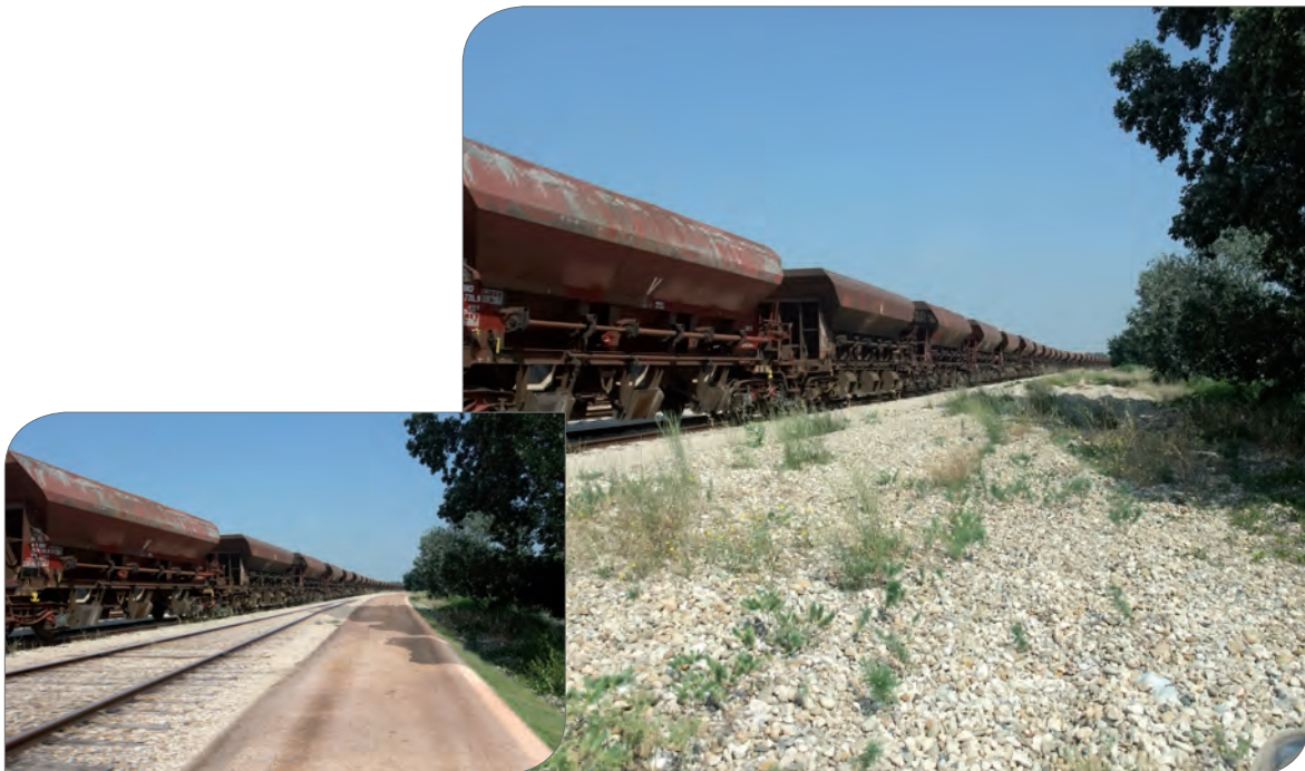
Réalisation d'une "diguette" calée à la cote Q_{1000} + 50 cm en extrémité Est du SIP d'Arles
