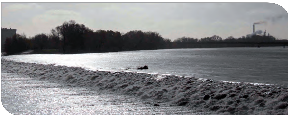
Déversoir de Barthelasse répartissant les eaux du Vieux Rhône vers le Rhône dérivé (CNR)
