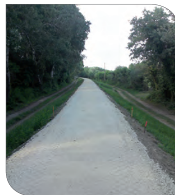
Digue en aval du RD35 rendue carrossable en 2010 (SYMADREM)
