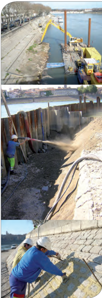
Réparations des quais Saint Pierre et Trinquetaille
