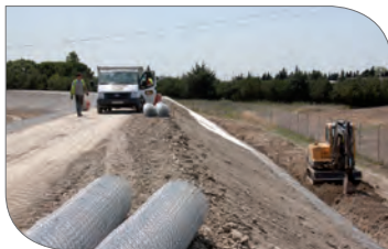
Pose du grillage anti-fouisseurs
