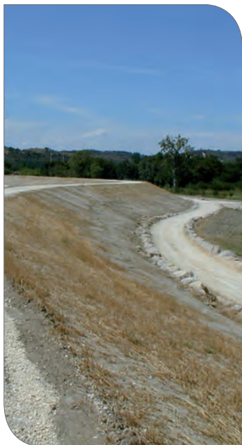
Digue résistante à la surverse d'Aramon (commune d'ARAMON et gestion SMAGE des Gardons)
