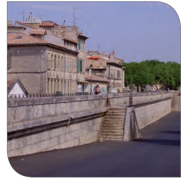
Digue de la Banquette
