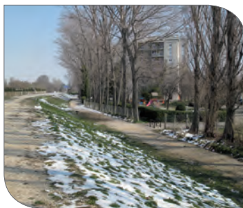
Digue de Barriol confortée en 2007 (SYMADREM)
