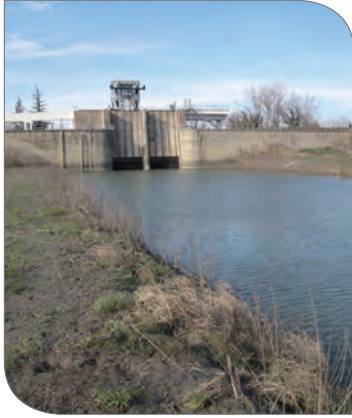
Prise d'eau sur le Rhône (BRL)
