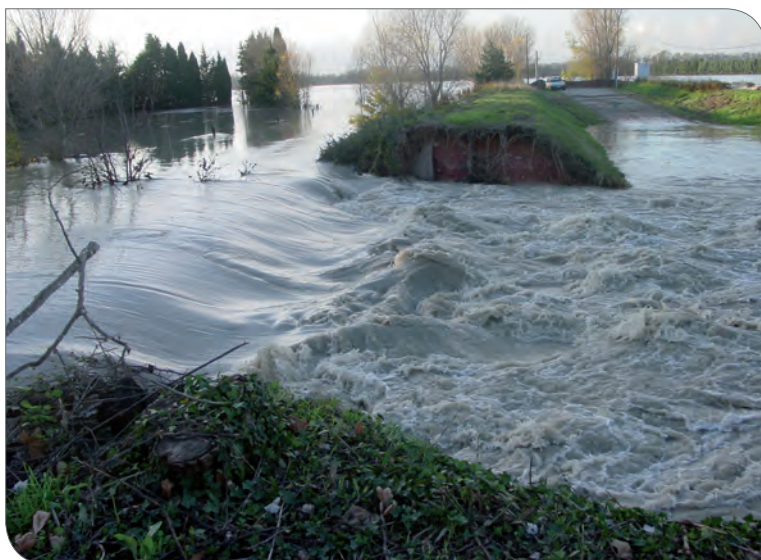
Décembre 2003 – déversement sur les digues de protection des trémies (© Ville de Tarascon)
