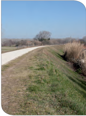
Digue du défluent confortée en 2000 (SYMADREM)
