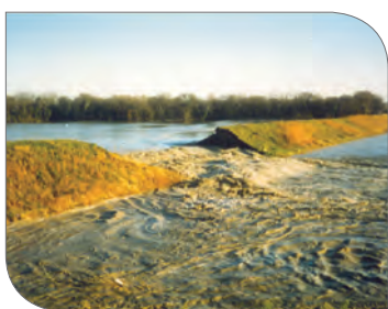
Brèche de Beaumont – janvier 1994
