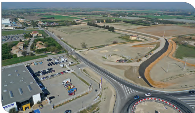
Digue nord d'Arles – Barreau de fermeture (SYMADREM)
