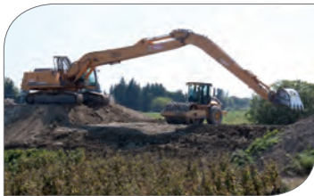
Mas de Rey – suppression d'un ouvrage traversant hors service et reconstitution de la digue
