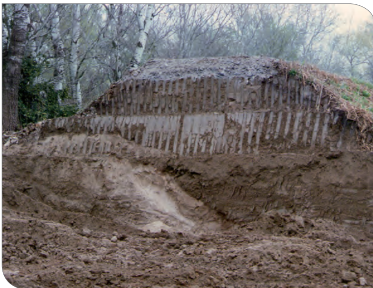
Ouverture de la digue suite à la crue de novembre 1996
