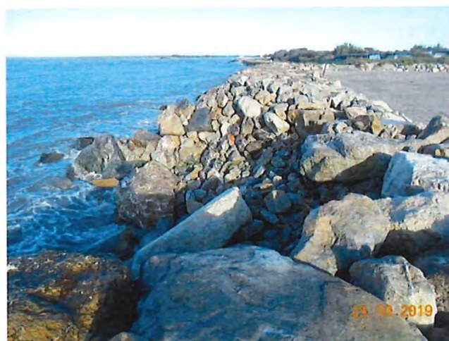
Photo 5. Rupture de l’épis tenon du clos du Rhône en octobre 2019
