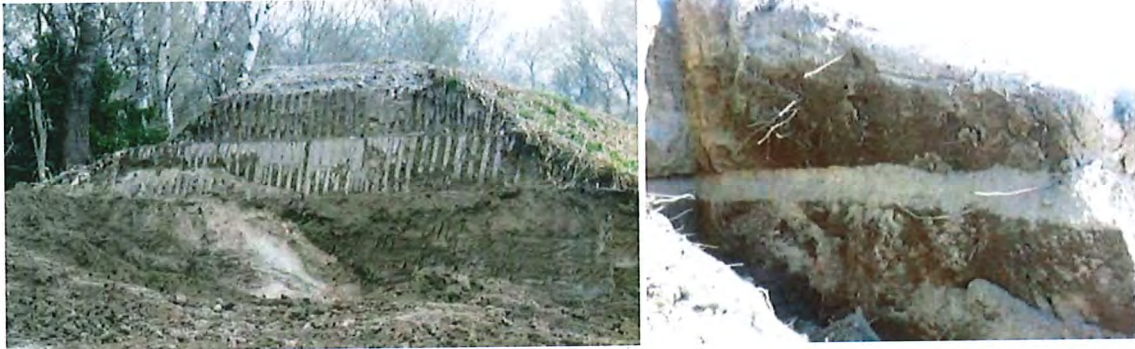
Photo 1. Diges du delta du Rhône – mille-feuilles et hétérogénéités (© Symadrem)
