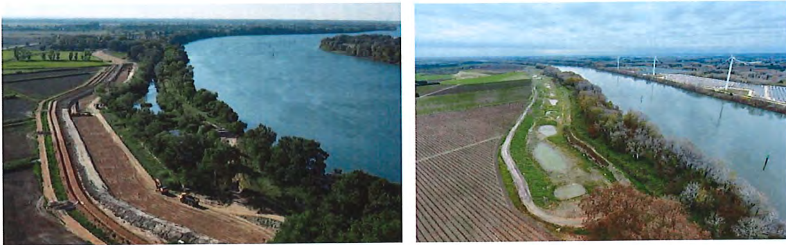
Photo 3. Démontage des digues d'origine, reconstruction en recul et création de zones humides (© Symadrem)
