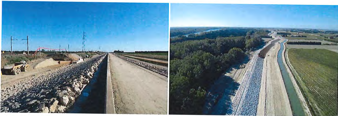
Photo 2. digues résistantes à la surverse de Tarascon-Arles et Beaucaire-Fourques (© Symadrem)
