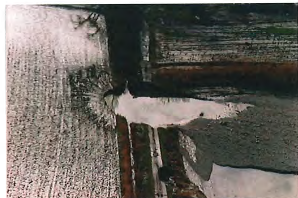
Figure 4. Exemple de brèche dans une digue avec sa fosse d'érosion (Durance)
