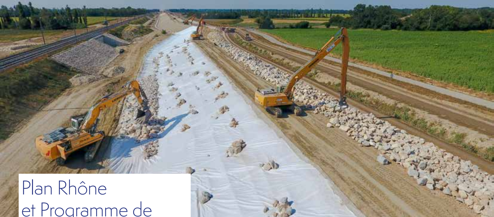
I Digue Tarascon-Arles
