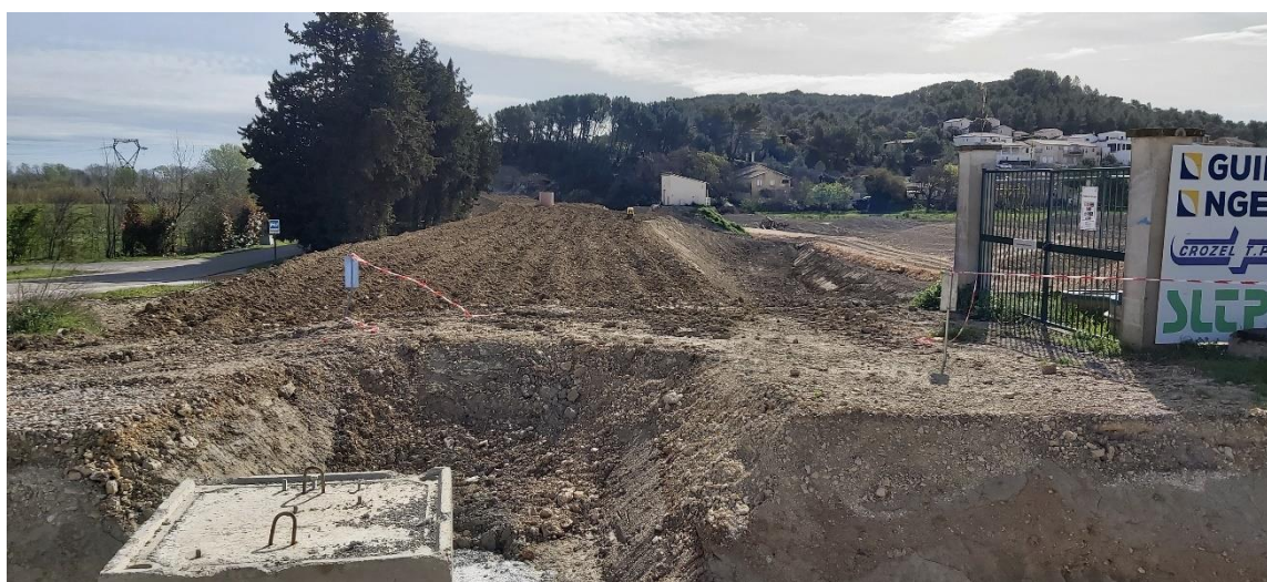
Rehaussement de la digue des Marguilliers
