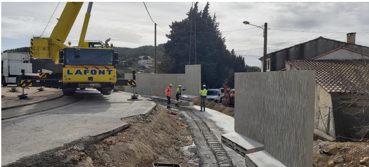
Mur de soutènement en accotement sud-ouest du giratoire
