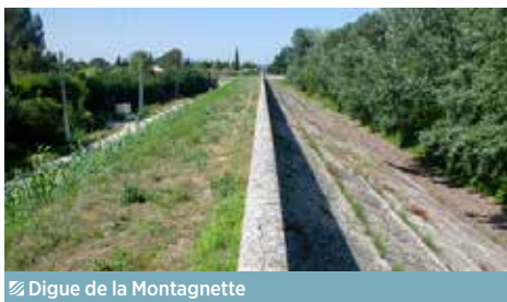
Digue de la Montagnette
