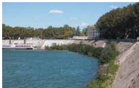
Travaux au quai Marx Dormoy
