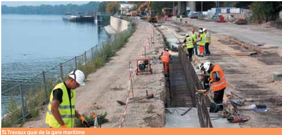
Travaux quai de la gare maritime
