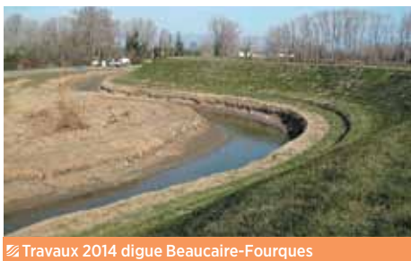
Travaux 2014 digue Beaucaire-Fourques
