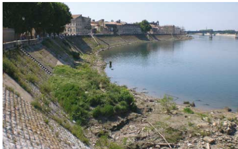
Avant travaux, état actuel Photo Symadrem
